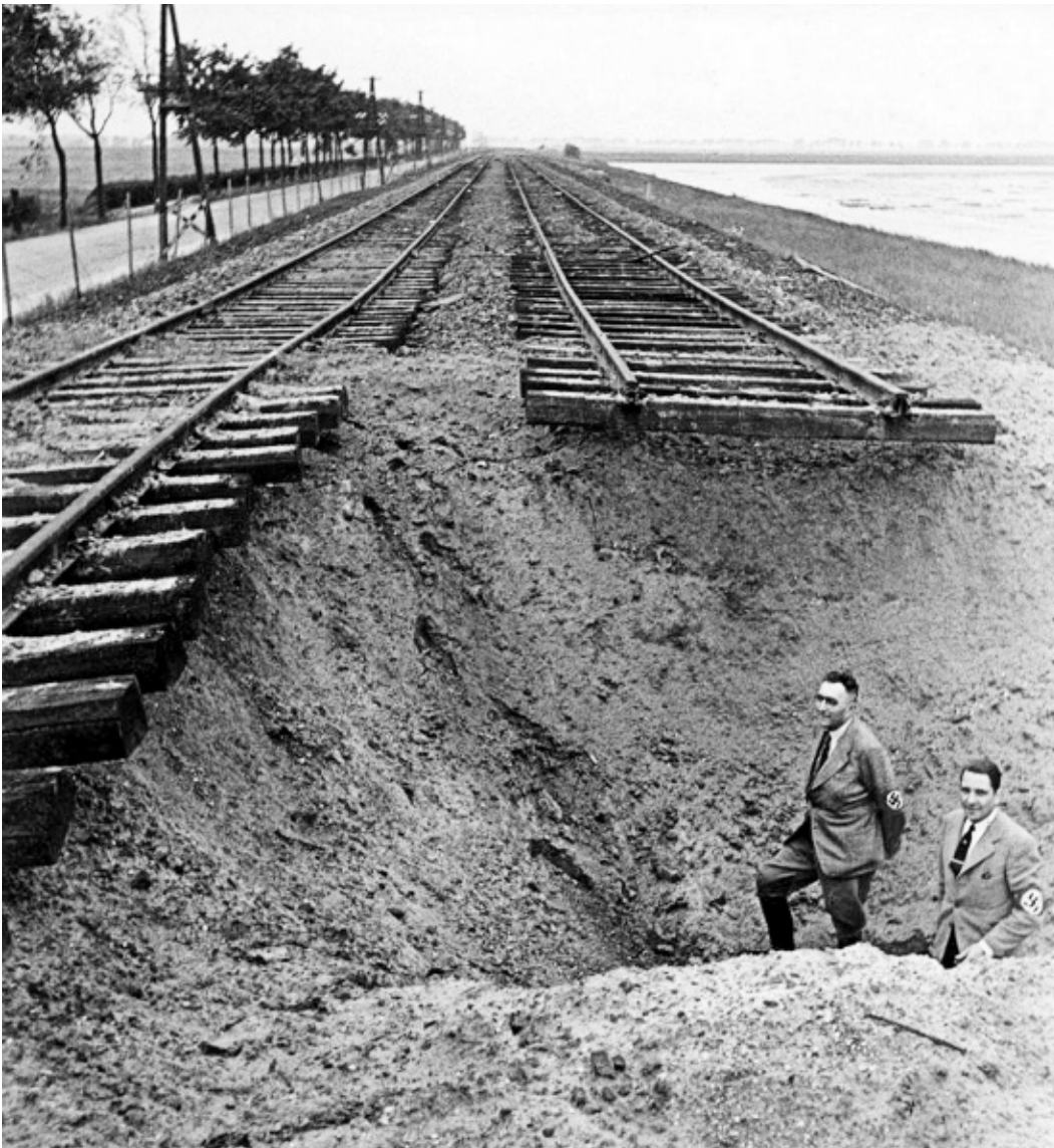
Sloedam. Herstelwerkzaamheden na geallieerde beschietingen en bombardementen. (Bron: Publiek domein)
